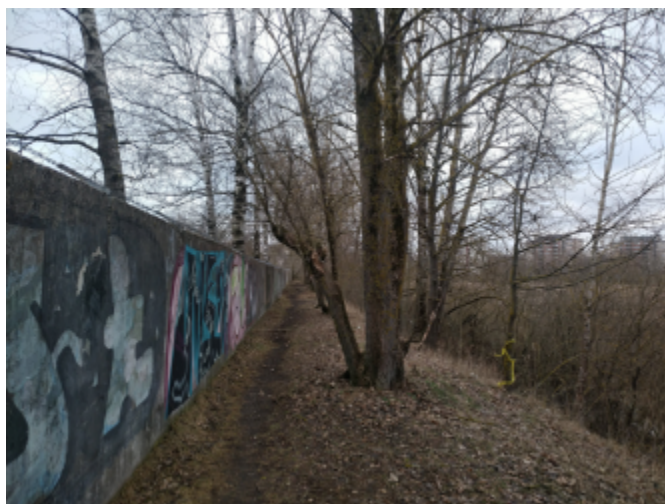
78 paveikslėlis. Dabartinė betoninė tvora ir šalia jos einantis takas (U. Valainio nuotrauka)
