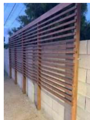
80 paveikslėlis. Medinių lentų skydai, kuriuos siūloma pritvirtinti prie betoninės tvoros
