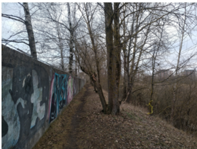
78. attēls. Attīrīšanas iekārtu teritorijas esošais betona nožogojums un iestaigātā taka (Foto: U. Valainis)
