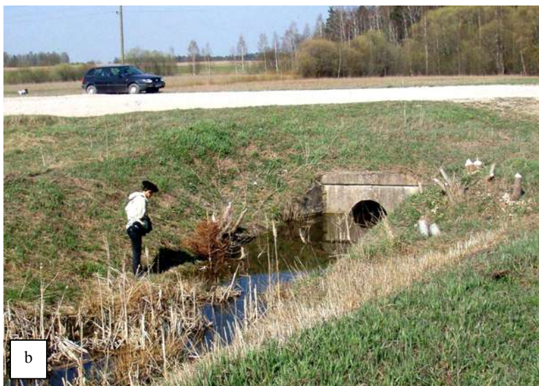
50.att. Ceļu plānošana: a) negatīvā: ceļi šķērso bruņurupuču biotopus, sadalot tos; b) pozitīvā: liela diametra tunelis-kanāls ļauj bruņurupučiem migrēt zem ceļa (Apgulde, 2008, 2009).
