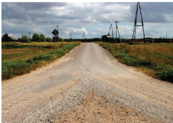
50.att. Asfaltēti un grunts ceļi šķērso purva bruņurupuča lieguma teritoriju, atdalot bruņurupuču apdzīvotus dīķus vienu no otra un no ezera. Apgulde, Dobeles novads.
