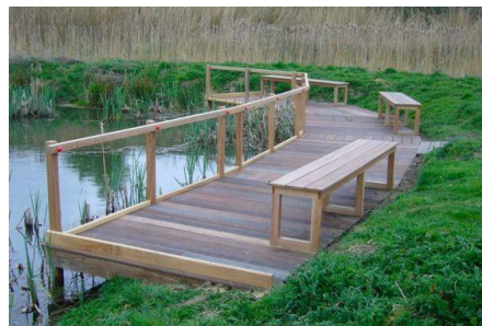
96. attēls. Platformas pie ūdenstilpēm piemērs
