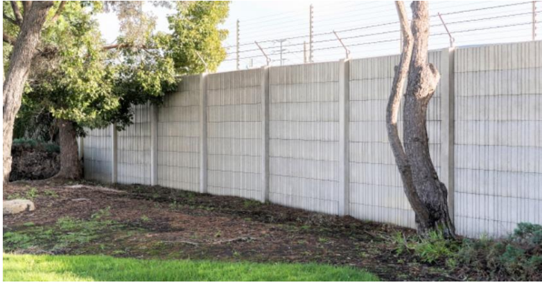
79. attēls. Betona nožogojuma krāsojuma piemērs
