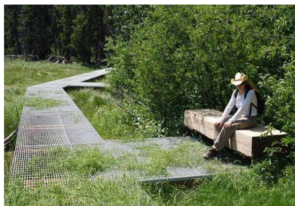
93. attēls. Paaugstinātas cinkota tērauda režģa laipas ar atpūtas soliēm piemērs
